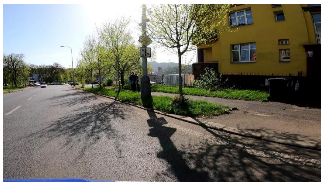
Obrázek 15: Špatná viditelnost SDZ P 2 Hlavní pozemní komunikace – zarostlé zelení.
